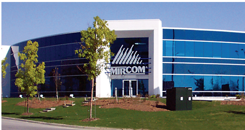
Oficina central corporativa y planta industrial, localizadas en Vaughan, Ontario, Canadá
